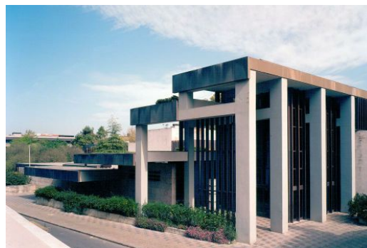
122. Centro de Arte Moderna da Fundação Calouste Gulbenkian
