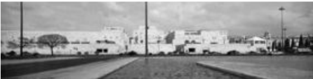
124. Fachada Sul do Centro Cultural de Belém.
